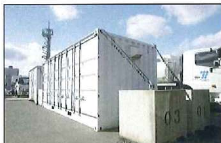
資材保管用コンテナの固縛対策
